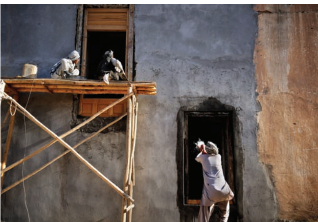
Bagh-e Jehan Nama Palace, renovation
